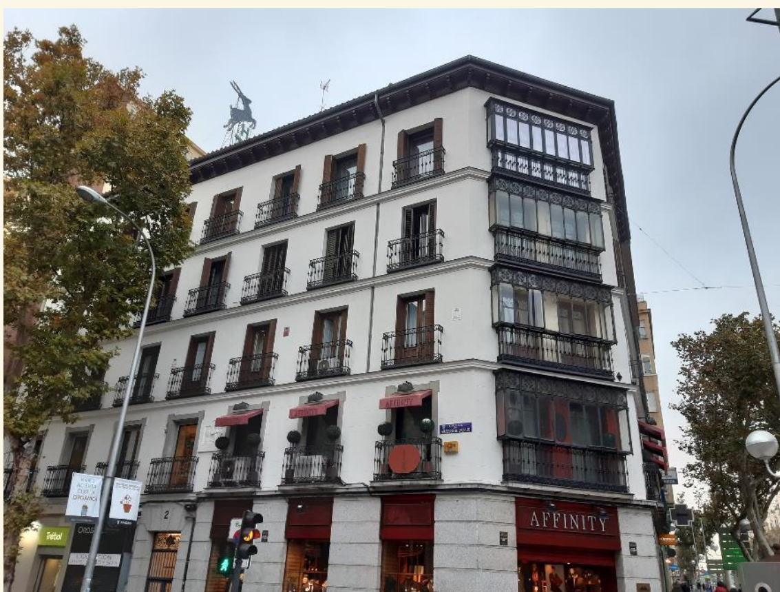
Figura 28. Madrid, calle de Marqués de Urquijo, 2. La familia Veiga ocupó el tercer piso izquierda, en chaflán. Se distingue la placa conmemorativa en el primer piso (Figura 39). Foto J. Campos, noviembre de 2019.
