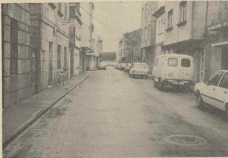
Rúa de Luis Seoane, que xunto con Luis Casais, tiña que ser pavimentada con aglomerado asfáltico. Como marcaban os proxectos.
