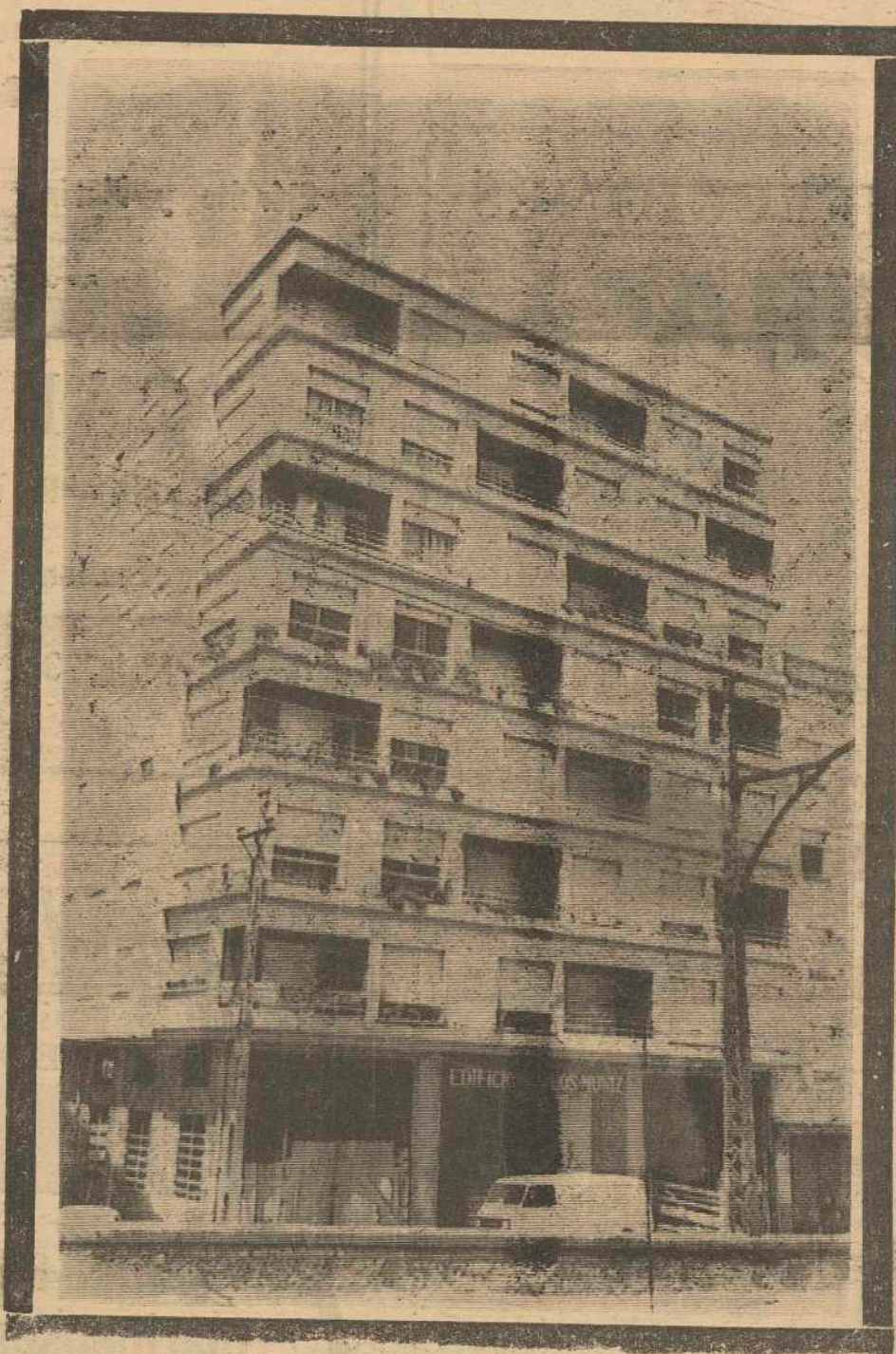
EDIFICIO CARLOS MUÑIZ
