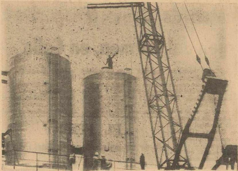
LUDWIGSHAFEN (DID). — En sus esfuerzos por un ambiente mejor protegido, la BASF se ha adentrado en un terreno nuevo técnicamente: Los residuos de ácido sulfúrico que se obtienen de diversos procesos, y que a causa de la protección ambiental tienen que ser neutralizados, serán depositados en el futuro, antes de su «tratamiento», en grandes containers de resina de poliéster reforzada con fibra de vidrio.
