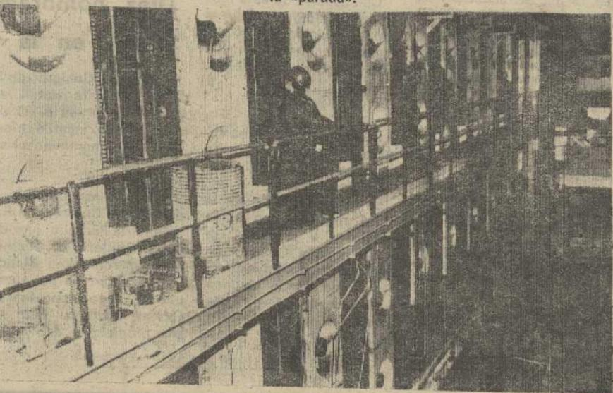
Operarios revisando un precipitador electrostático de captación de partículas sólidas en los humos de las calderas de recuperación.
