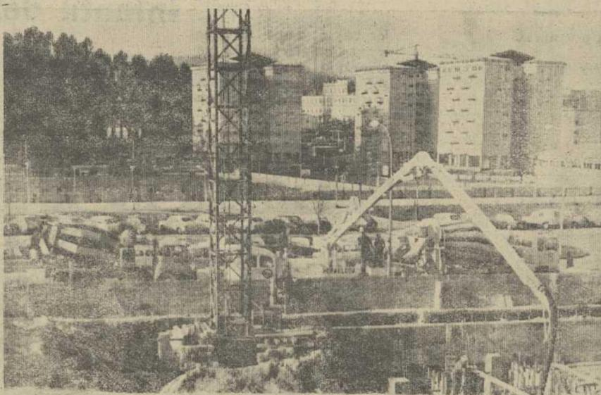
No hay lugares inaccesibles para la Whiteman. Este poderoso auxiliar de la construcción consta de una pluma de 3 secciones, fabricada en aluminio, con altura libre al suelo de 33,5 metros, bajo ángulo de 70° y con tubería de 127 milímetros de diámetro. HORAGLOSA la pone en Pontevedra al servicio público de todo aquel que solicite sus servicios. — (Foto RUIZ).
