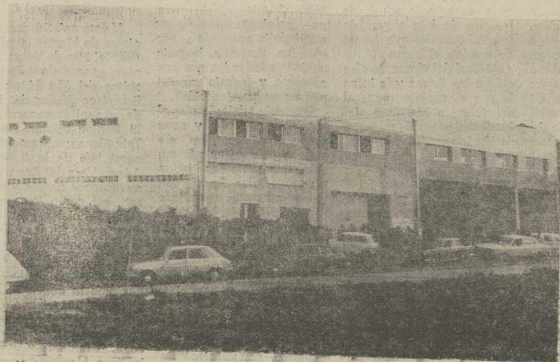
Un aspecto de la parte exterior de "Muebles Arosa", ubicada en Santa Cristina de Cobres (Vilaboa).
