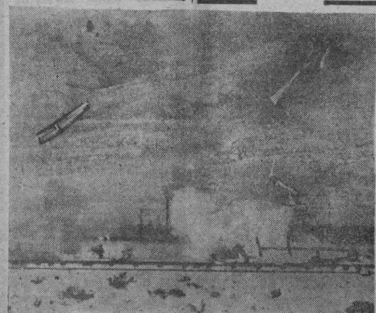
Un momento de las pruebas, realizadas utilizando muñecos del tamaño de una persona, del nuevo sistema automático para el salvamento de pilotos, ideado para los aviones a propulsión de la Marina norteamericana.
