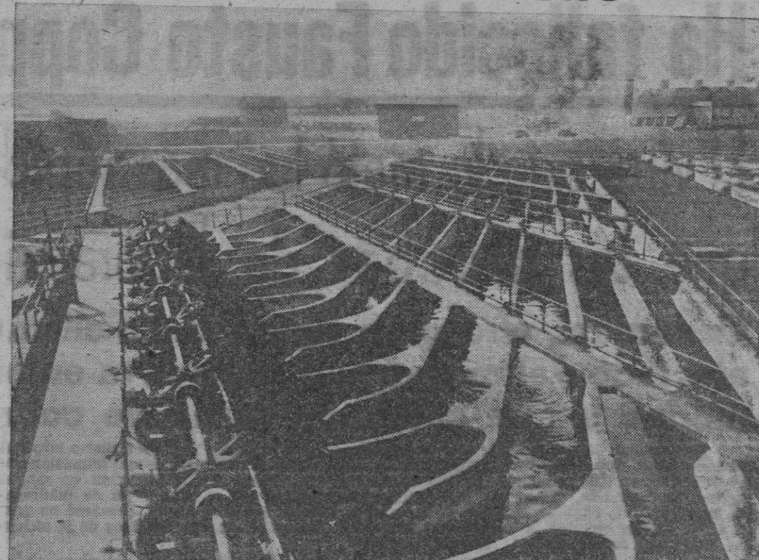
Canales de aireación de cieno de la instalación de aguas residuales de Becton
