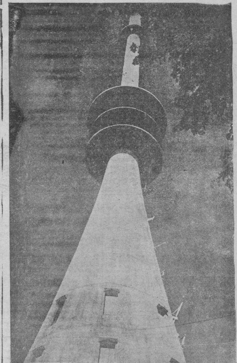
En los bosques de Baviera ha sido instalada una de las más importantes estaciones de televisión alemana. Esta es la parte superior de la torre, que mide la respetable altura de cien metros
