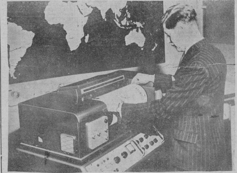
Un operador carga el cilindro del Transmisor de Páginas Muirhead por Sistema Facsimil (aparato que permite recibir copias fotográficas de originales a muchos centenares de kilómetros de distancia)
