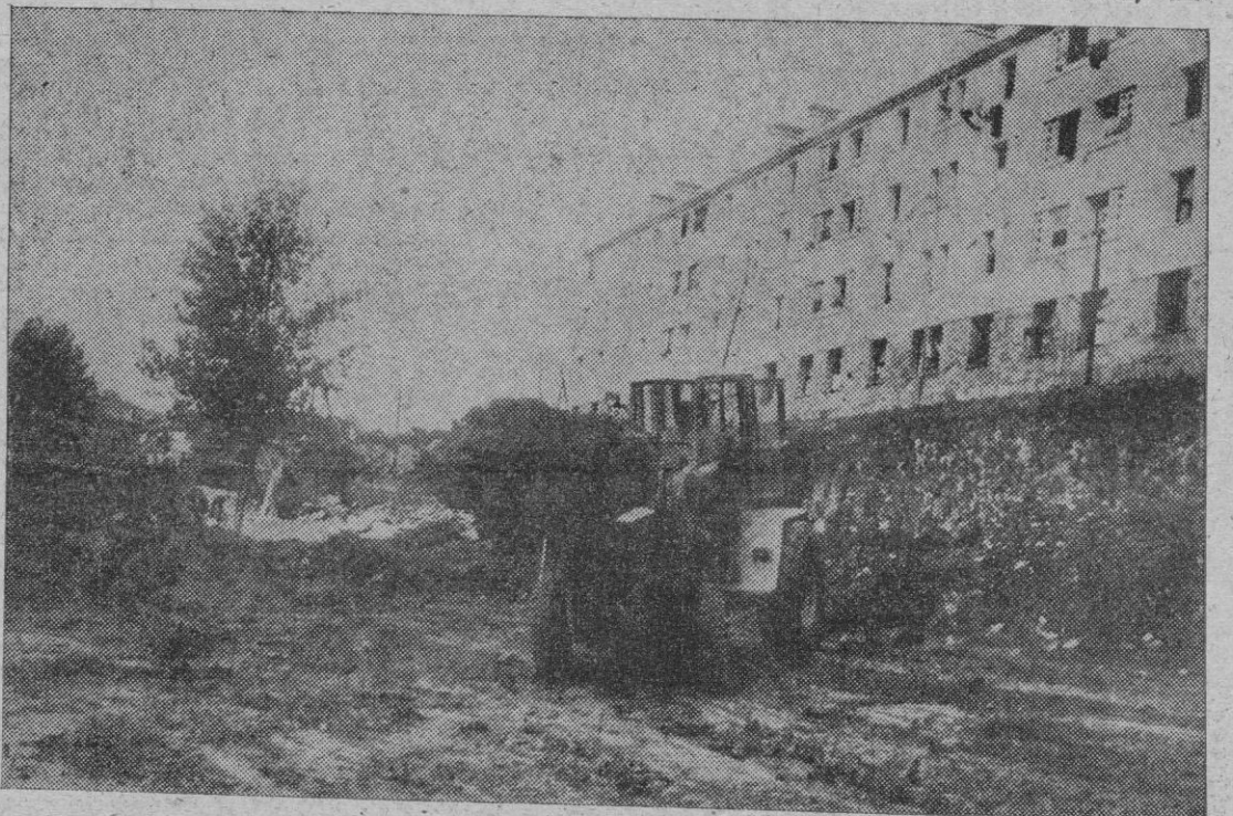
Maquinaria moderna se utiliza en las obras de la Avenida Juan XXIII, en Santiago
