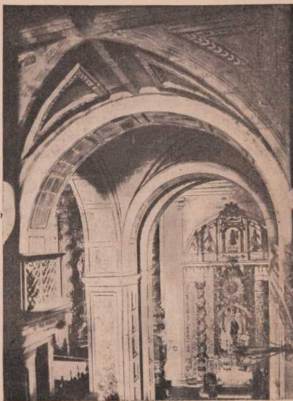
FIG. 4.—Interior de la nave de la Epístola
