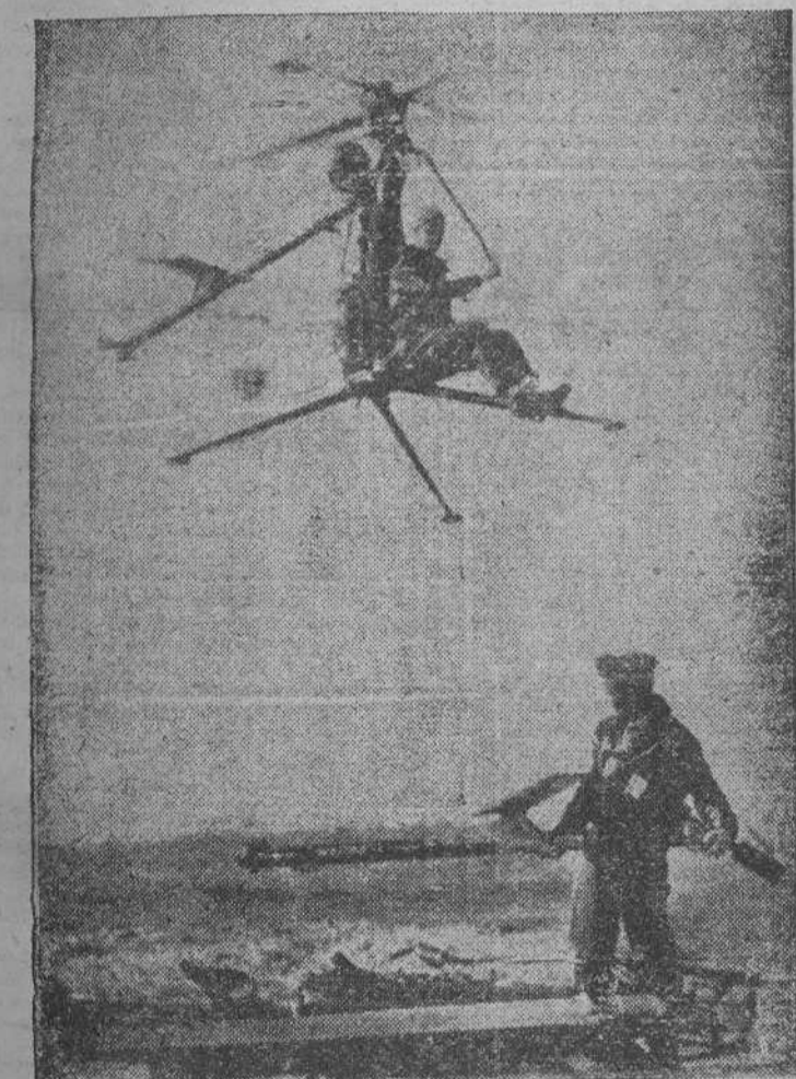
La Infantería de Marina norteamericana utiliza este tipo de helicóptero monoplaza, desmontable, que sirve para acciones paracaidistas y similares. Tiene escaso peso y lleva un motor de cuatro cilindros a gasolina.
