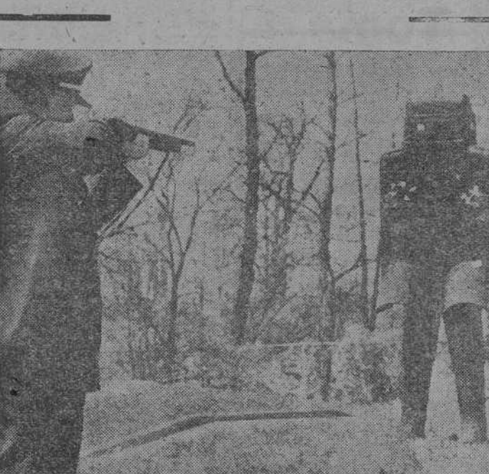
En Detroit, un inspector de Policía prueba la resistencia de una especie de "robot" de plástico. Las balas de calibre 45 no perforaron la capa de plástico
