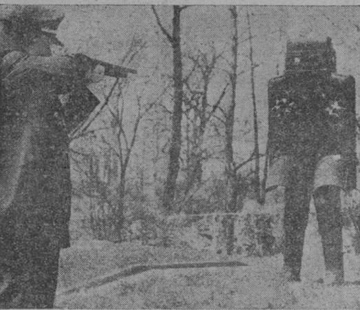
En Detroit, un inspector de Policía prueba la resistencia de una especie de "robot" de plástico. Las balas de calibre 45 no perforaron la capa de plástico
