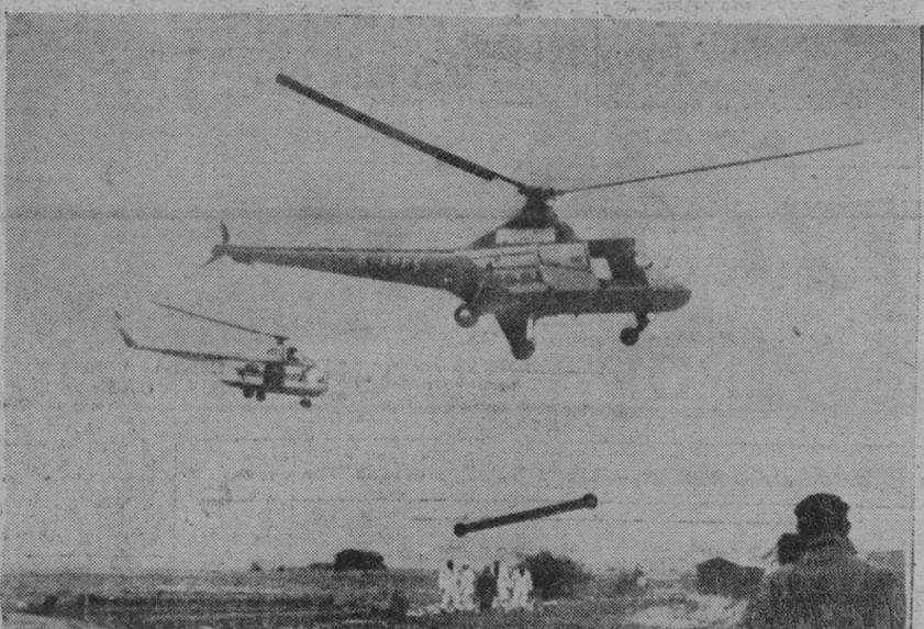
Por primera vez en Inglaterra, un helicóptero ha sido empleado para colocar una línea de tubos de la Associated Portland Cement Manufacturers, que se usará para transportar mezcla líquida de cemento. En la fotografía, el helicóptero se dispone a descargar una de las secciones sobre los pantanos Cliffe. — (Foto San Antonio)
