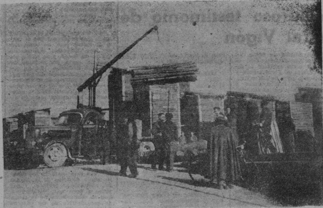
Un modelo de grúa "Hiab" realizando operaciones sobre un camión en el muelle de Puente-cesures
