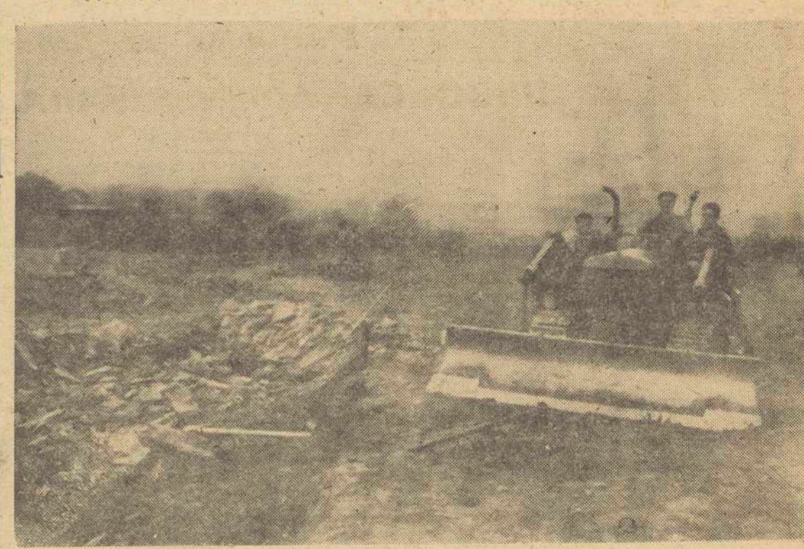
La carretera de Outeiro a la vía principal. — (Foto «ARJO»).
