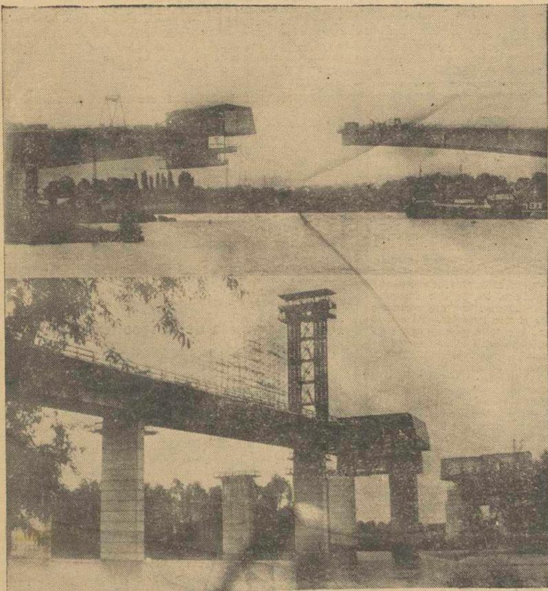
COBLENZA. (Impresiones de Alemania). — Entre las ciudades de Neuwied y Coblentz está en vías de construcción un nuevo puente sobre el Rin. Este puente de autopista consiste en dos trayectos paralelos de una longitud de 515 metros, cada uno de dos vías de viaje y una vía de estacionamiento así como de sendos caminos anchos para ciclistas y peatones. Técnicamente se caracteriza la obra por su construcción de pilar en pilar sin andamios ni apoyos desde las dos riberas simultáneamente.
