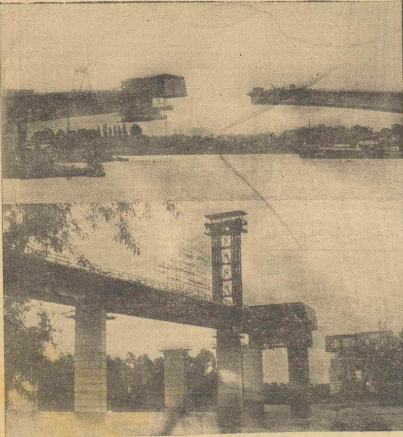
COBLENZA. (Impresiones de Alemania). — Entre las ciudades de Neuwied y Coblenza está en vías de construcción un nuevo puente sobre el Rin. Este puente de autopista consiste en dos trayectos paralelos de una longitud de 515 metros, cada uno de dos vías de viaje y una vía de estacionamiento así como de sendos caminos anchos para ciclistas y peatones. Técnicamente se caracteriza la obra por su construcción de pilar en pilar sin andamios ni apoyos des de las dos riveras simultáneamente.
