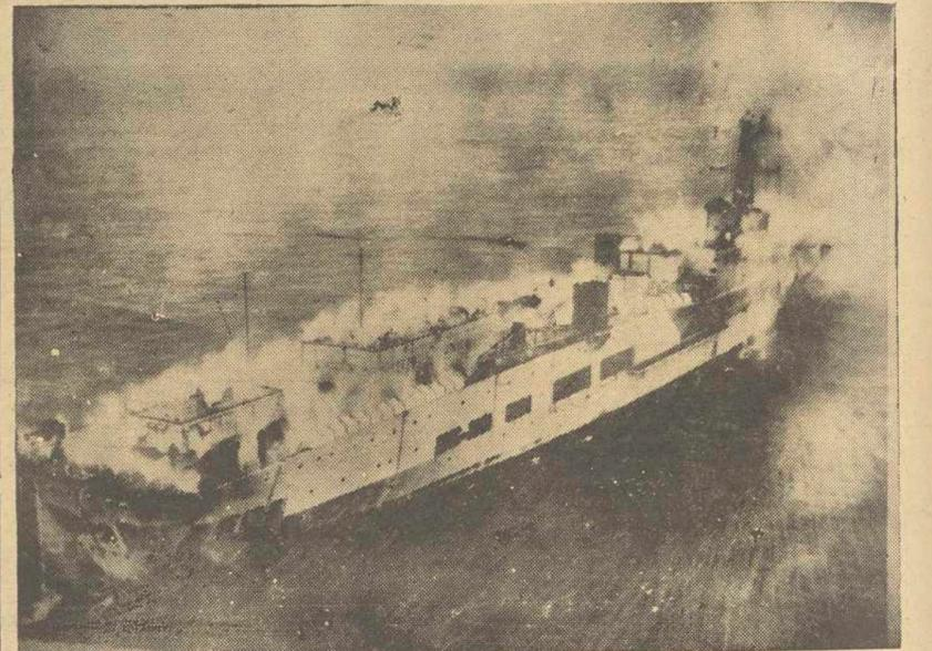
El navío de guerra británico "Triumph", construido en principio como portaaviones ligero y transformado ahora en buque de escolta y apoyo de destructores y fragatas, visto desde el aire en el momento en que actúan los surtidores de agua instalados en el mismo para lavarle de toda radiactividad después de un ataque atómico, en el curso de unas maniobras. — (FOTORIEL).
