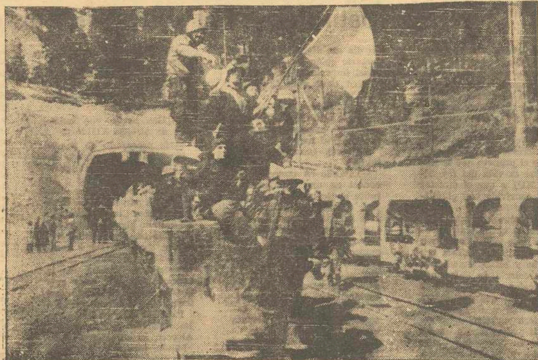
SAN BERNARDINO (Suiza). -- Ha terminado la perforación del segundo túnel a través de los Alpes que conecta la región de los Grisones con la parte meridional de Suiza. En la foto, un grupo de obreros que viajaron en el tren de vagones inaugural.— (Foto Europa Press)
