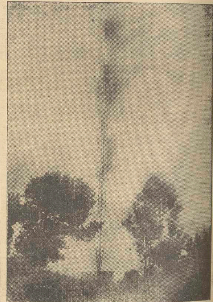
Antena de Radio Galicia, con doble función. Además de poste radiante de onda media, lleva incorporada la de Frecuencia Modulada. (Foto SANTISO)
