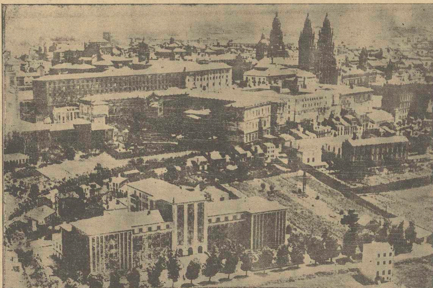
Vista aérea de Santiago de Compostela. El Hospital actual y a su lado los terrenos adquiridos por el Ministerio de Educación Nacional para la construcción del nuevo Hospital
