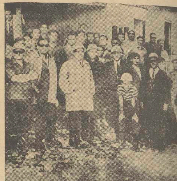
Los técnicos de la obra, con el Alcalde de la ciudad, señor Cenalmor Ramos y periodistas locales, posan entre los obreros que trabajan en la boca núm. 4 del túnel núm. 2 (Foto Paadín Jr.)
