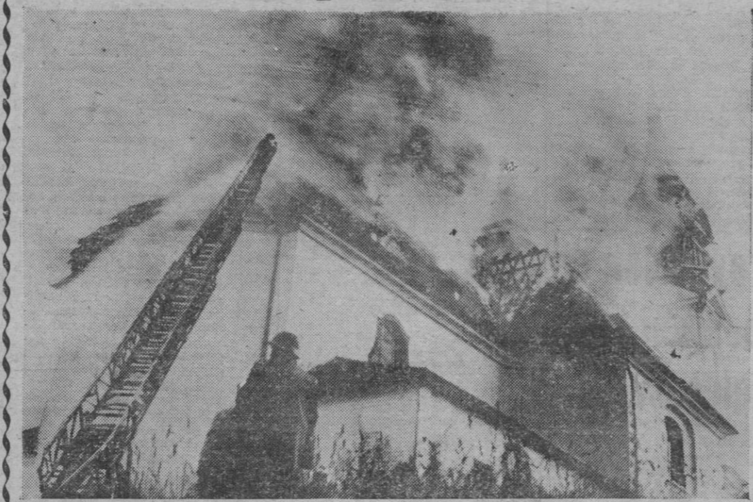
LINZ. — Un violento incendio ha destruido la iglesia de Postlinberg de Linz, auténtica joya del arte barroco austriaco. Hace dos años fué restaurada en cuyos trabajos se gastó mucho dinero. La imprudencia de un obrero, que trabajaba con un soplete eléctrico, ha provocado el incendio que ha destruido esta joya arquitectónica y al mismo tiempo lugar de peregrinaje. En la foto un momento del incendio. — (Foto EUROPA PRESS).
