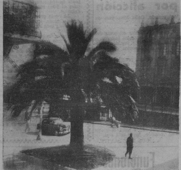
La plazoleta del Jofre con el espacio que Vds. ven, formará la Plaza de Alonso Vega, Del Palacio de Comunicaciones solamente vemos la palmera y parte de sus floridos y artísticos balcones. (Foto Arjo)
