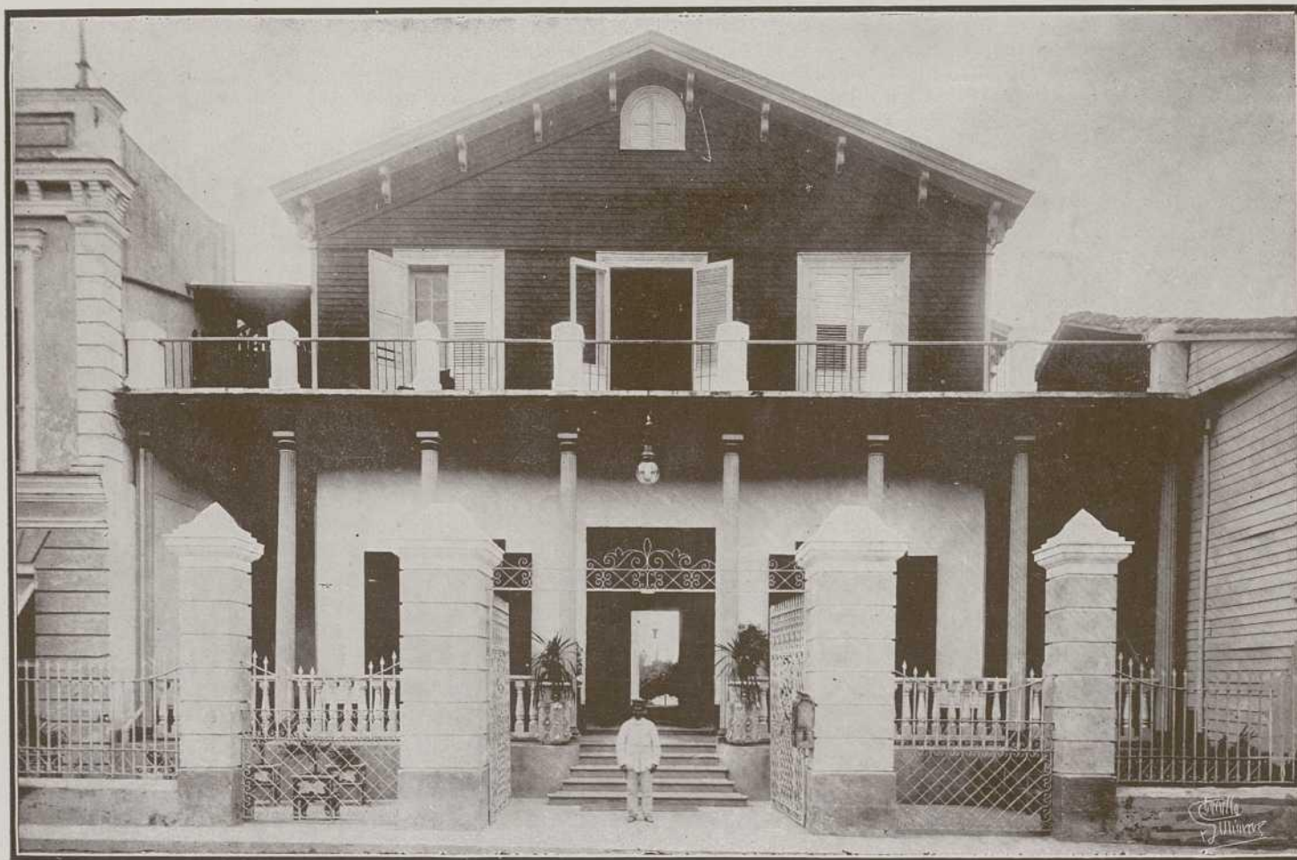
Primitivo edificio de "La Benéfica"
