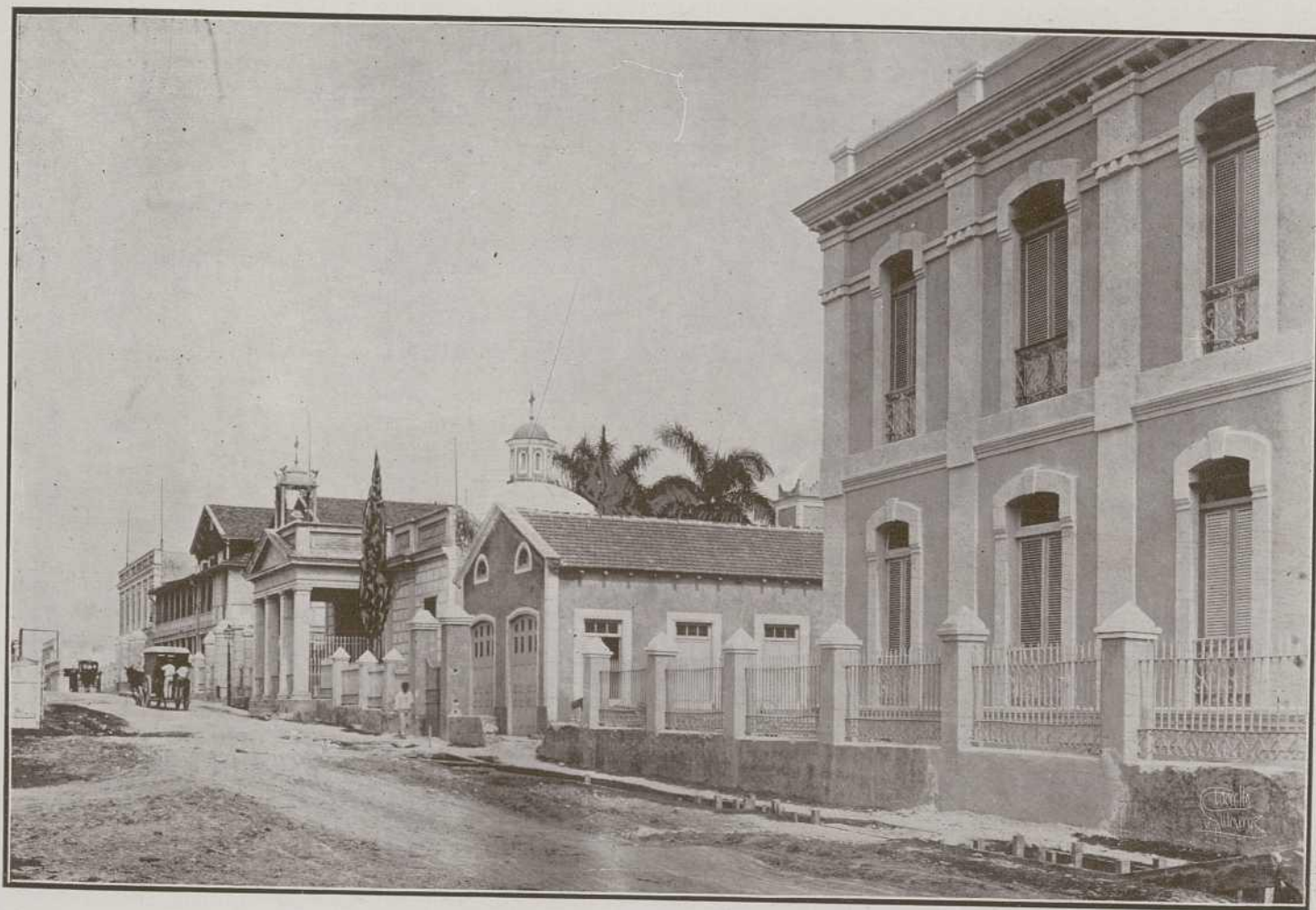
“La Benéfica” vista por la calle de Arango
