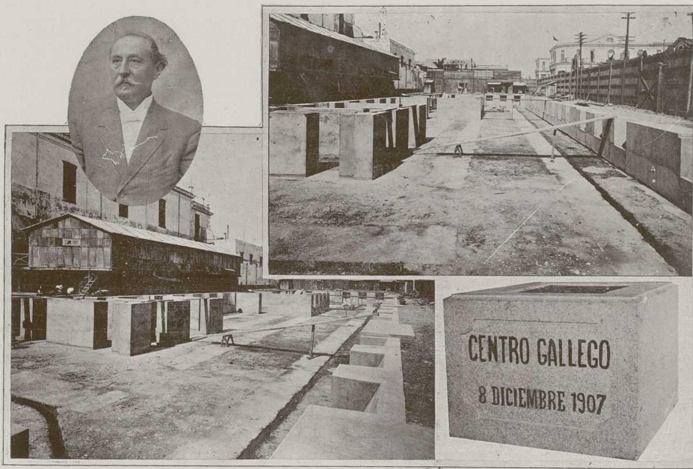
Ingeniero Sr. Rayneri que dió principio á los trabajos de cimentación, aspecto de éstos y primera piedra traída de Galicia para el nuevo Palacio del "Centro Gallego"
