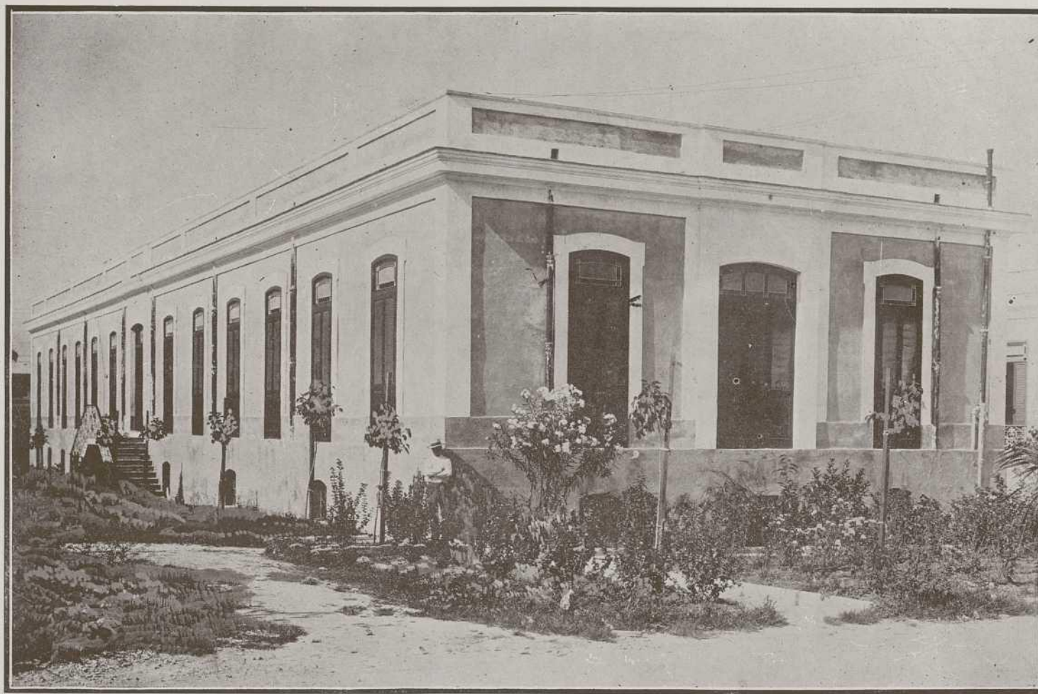
Pabellón núm. 14 para Enfermedades infecciosas
