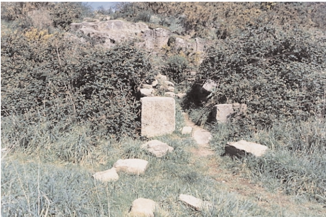
PEDRAS CAÍDAS NO UMBRAL DA MESMA CONSTRUCCIÓN
