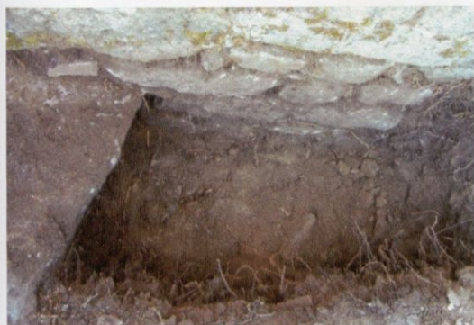
Detalle de la zanja de drenaje en la zona de la cabecera de la capilla.
