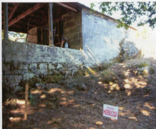
Desbroce y tratamiento de la vegetación.
