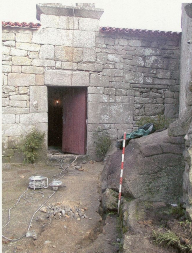
Fot. 7. Segundo tramo da zanja en rocha
