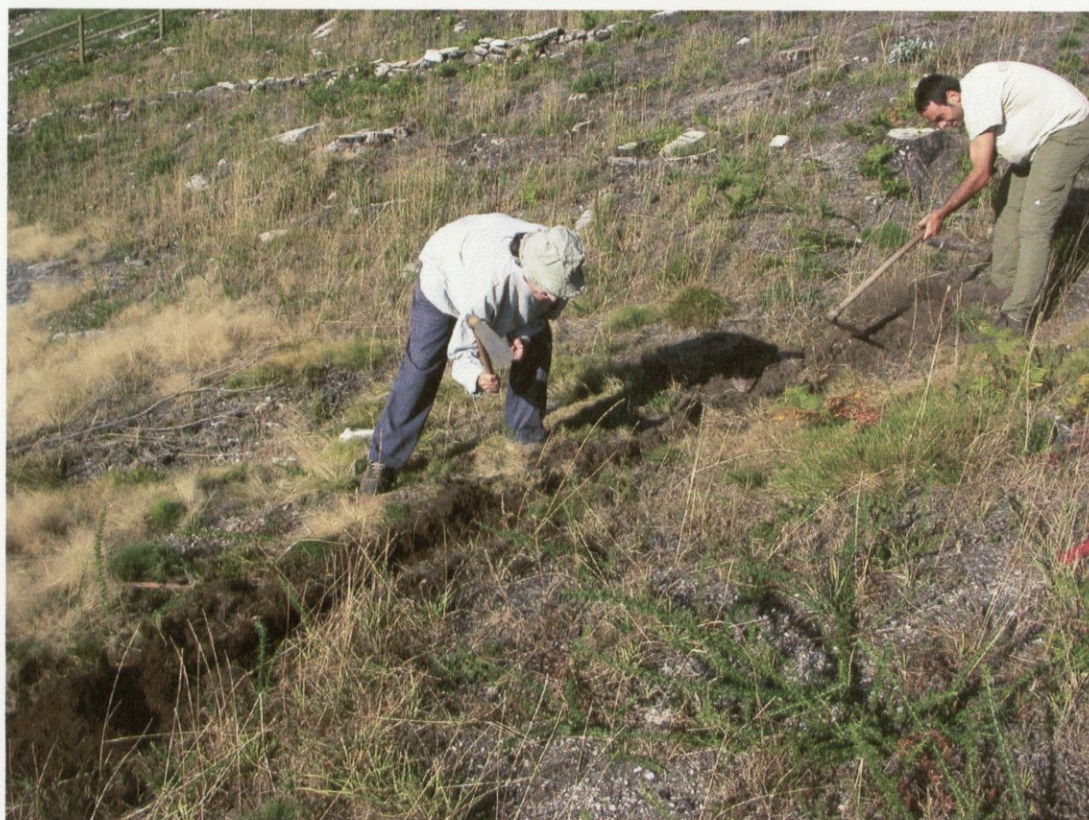
Realización de la zanja de drenaje
