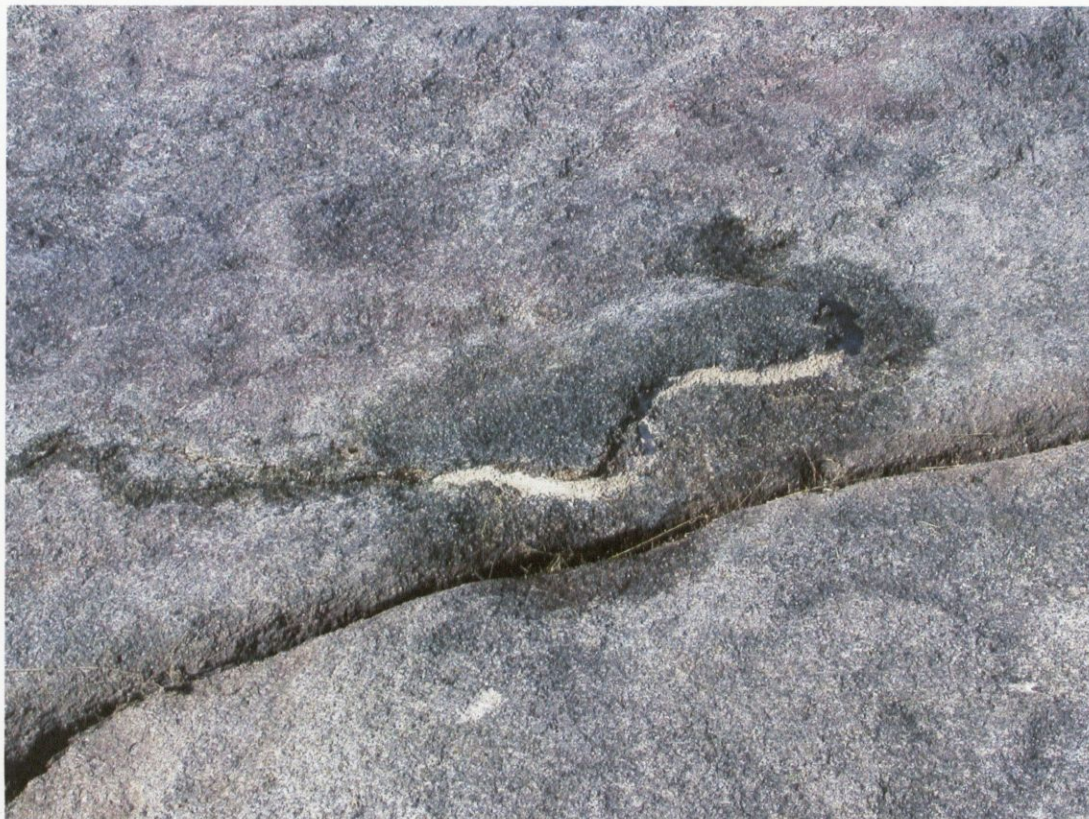
Consolidación de fisuras.
