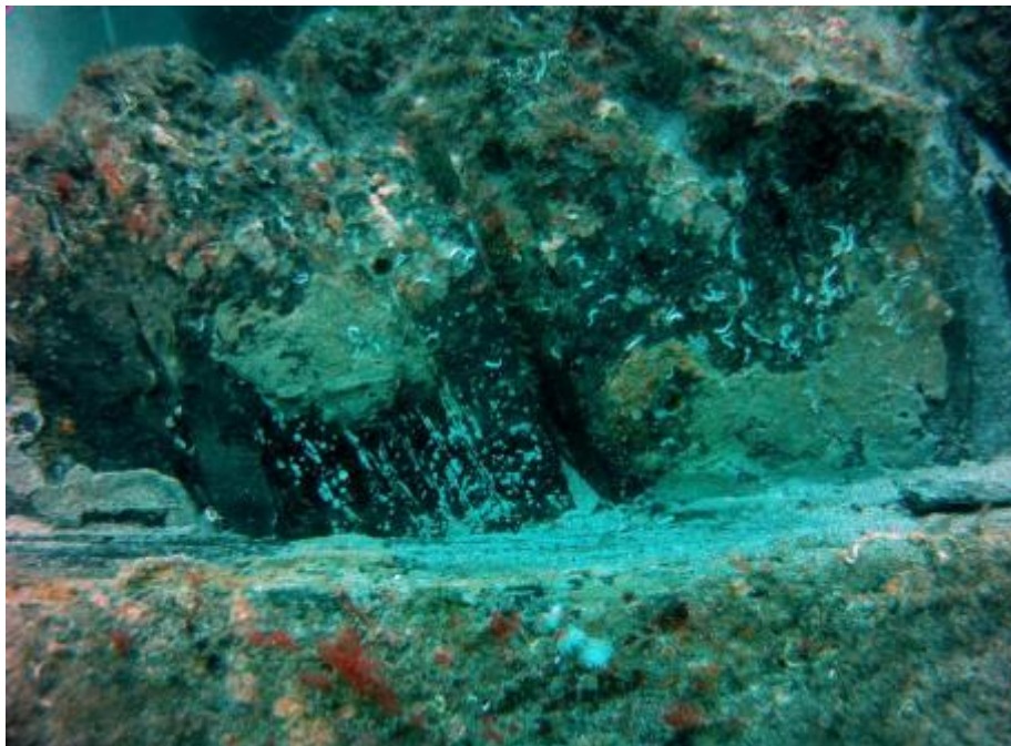
Aspecto do forro exterior no primeiro plano e das cadernas en segundo termino, unidas a oso sen claras entre elas, e donde se aprecian os ocos deixados pola desaparición dos cravos.
