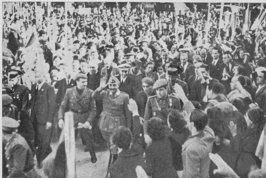
La Coruña.—Aspecto parcial del momento de la llegada del Generalísimo al pueblecito de Cayón
