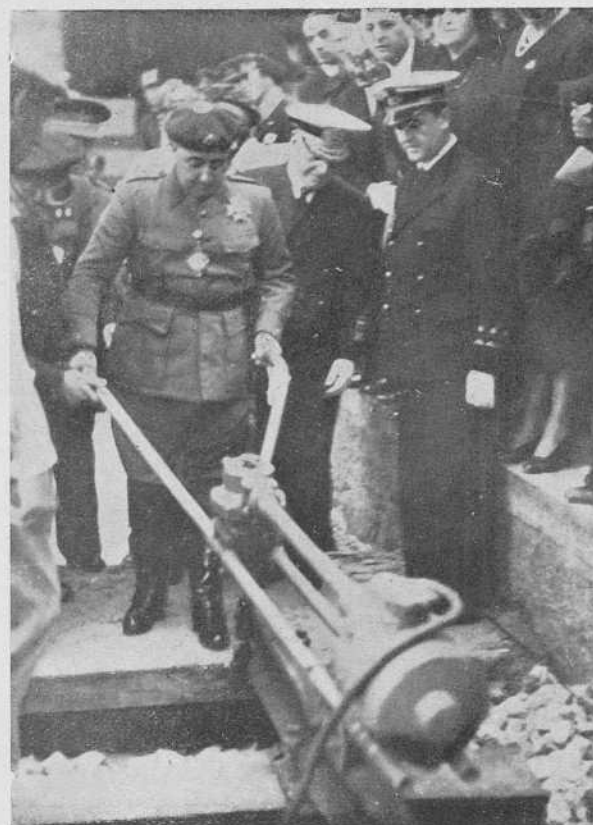
La Coruña.—Colocación del raíl de la línea Coruña - Zamora
