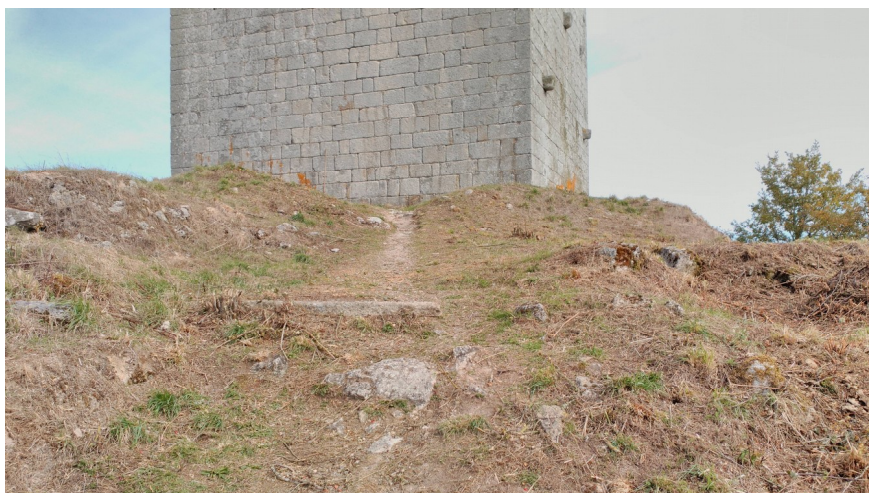
Imaxe 1 Vista da cara Sur da torre despois da roza
